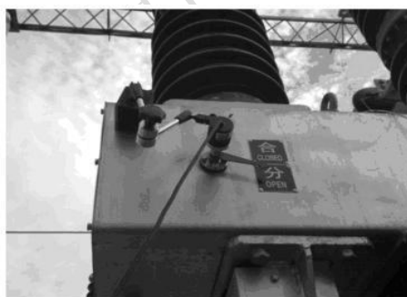
35KV SF6 开关传感器安装
